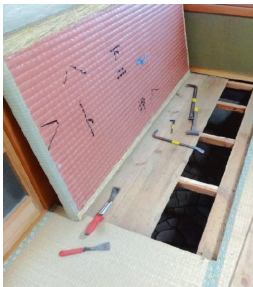
和室の床板をはがす（写真①）
