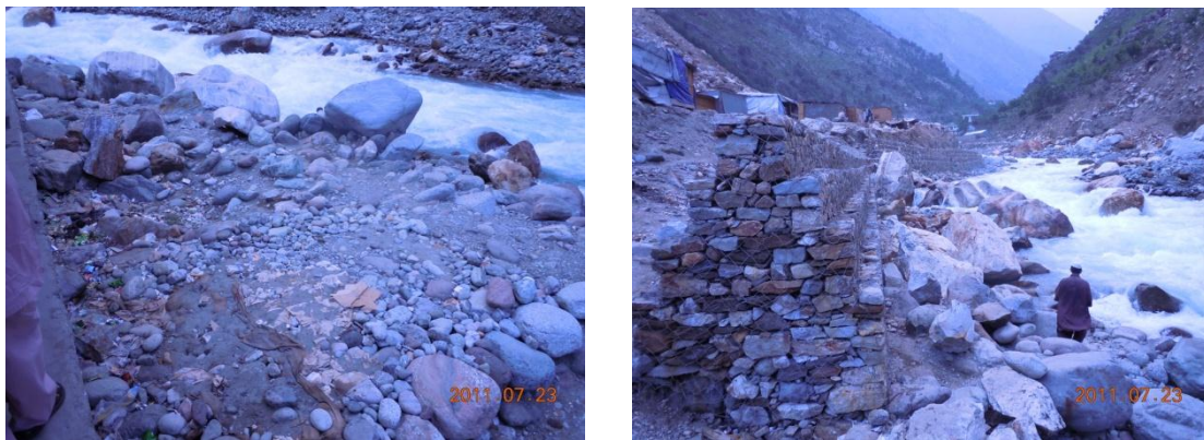
図 1-1-1 バザール・ラノリア小学校跡地 (左) とその付近における堤防建設現場 (右)
