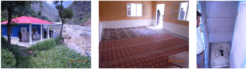
図 1-2-6 バーカレイ小学校の仮設校舎とトイレ
