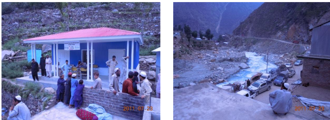
図 1-1-2 設置された仮設校舎 (左) と校舎から見下ろすドゥベイル溪流 (右)
