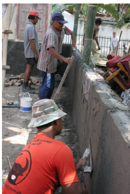
耐震シェルター 基礎部分の建設
