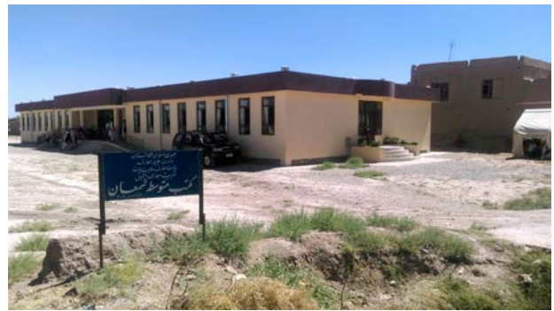
ヘラート州シャルマン校（NICCO建設）
