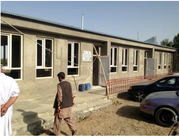
JENによるパルワン州での学校建設現場
