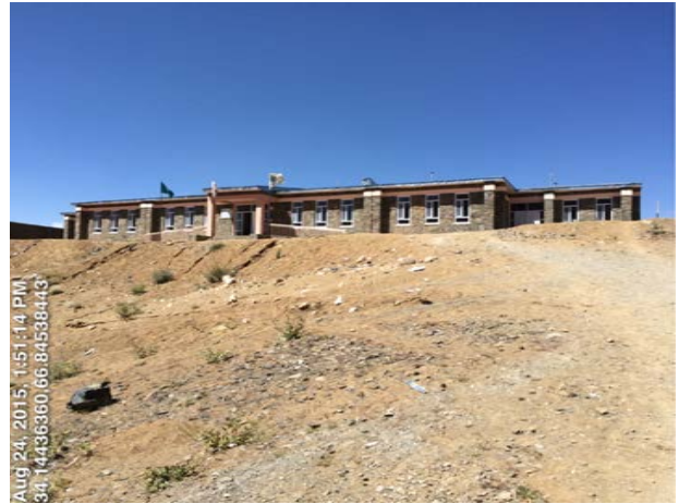
ADRAによるワラス地区学校建設
