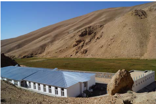
バーミヤン州Gombaz School 外観
