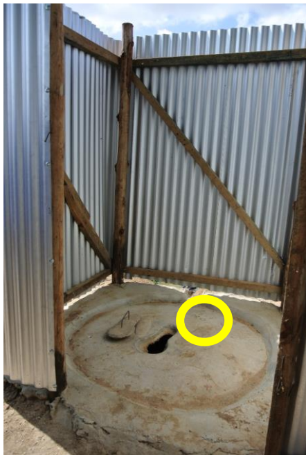
写真 5：建設中のトイレ。スラブには Oxfam と刻印されているが、PWJ の団体名は壁を含め、まだ入っていない。
