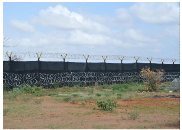
写真 2：7 月訪問時より補強されたフェンス。
