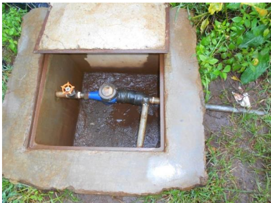
パイプを追加し、2ヶ所への配水を可能にした。
