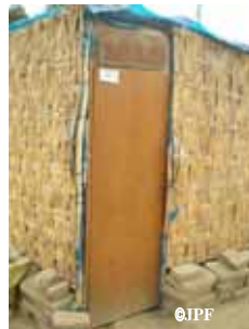
Estructura simple con esteras y puerta, y forro plástico para evitar ingreso de arena
