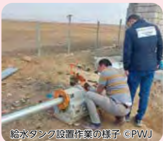
給水タンク設置作業の様子 ©PWJ
