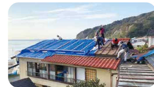
台風15号で大きな被害を受けた千葉県鋸南町でのブルーシート張り支援 ©PBV
